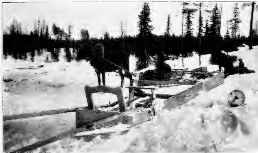
Fig. 14. Kombinerad snöplog och väghyvel.
